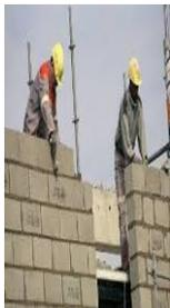
Un maçon va devoir construire des murs droits, parfaitement verticaux ou d'aplomb. Il va aussi construire des sols plats, parfaitement horizontaux. Enfin il va devoir réaliser des angles droits, d'équerre.
